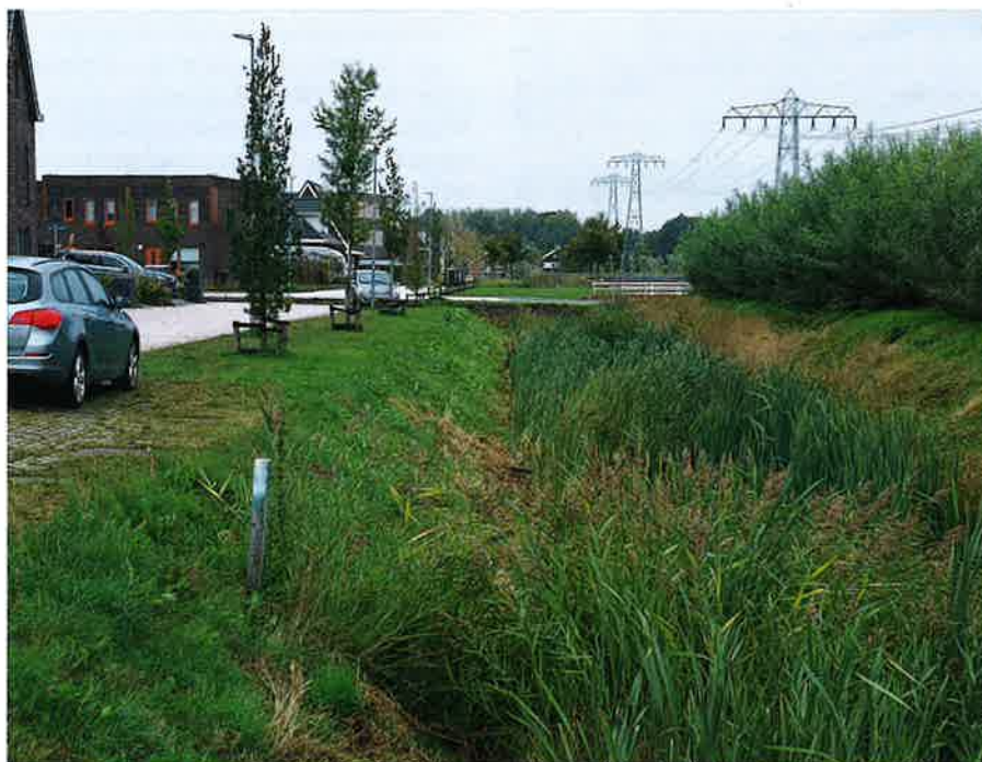
Wadi's ontvangen en 'verwerken' het afstromend water.
