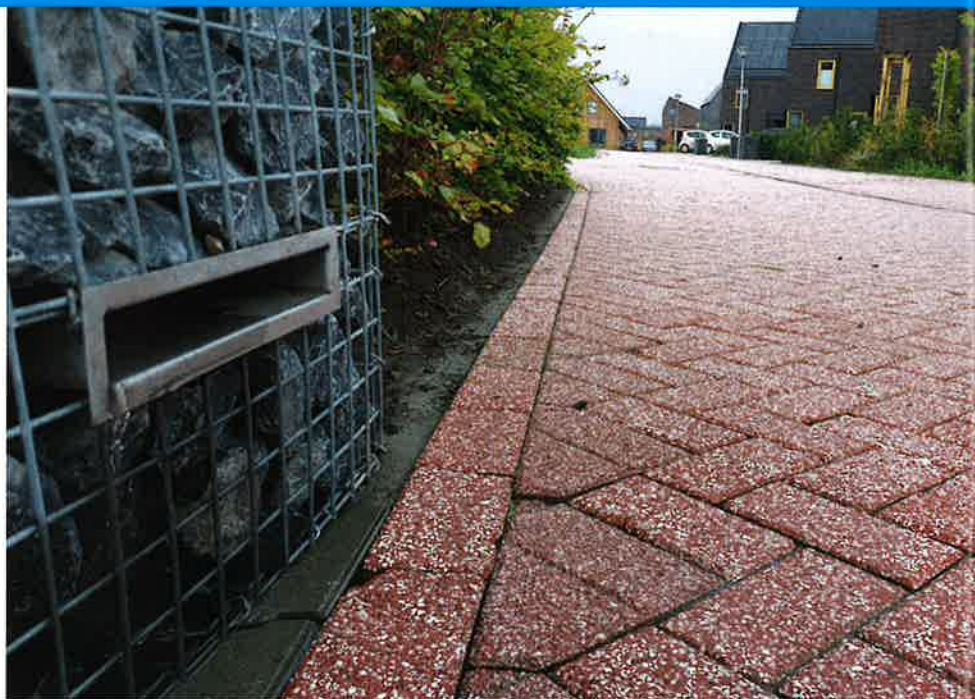
Waterspuwer waaruit het water vanaf de perceelgrens naar de kolkloze, openbare weg stroomt.
